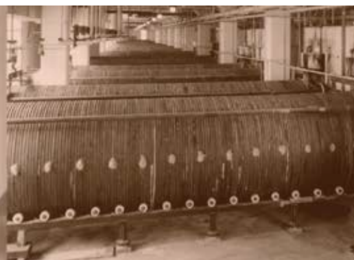
167 MW de potencia (NEL Hydrogen, Rjukan, Noruega)
